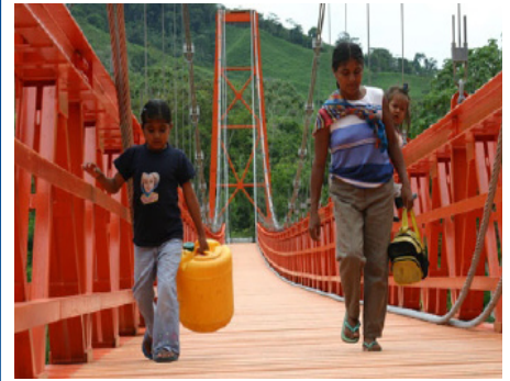
Este puente en Uchiza, departamento de San Martín, fue construido por USAID para apoyar a las comunidades circundantes en su transición hacia estilos de vida lícitos.
