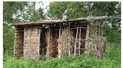
Avant la construction de nouvelles latrines à l'école primaire de Muja à Goma
